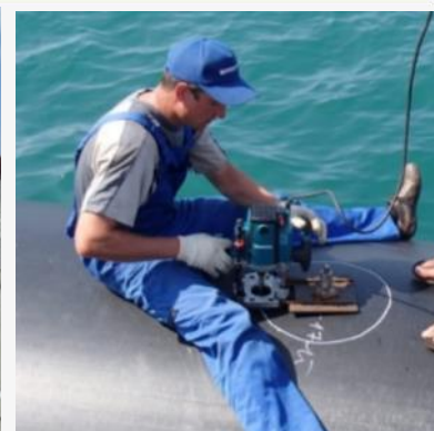
Олимпиада, строительство глубоководного выпуска в Сочи, техническое решение: врезка патрубков диффузора по месту.
